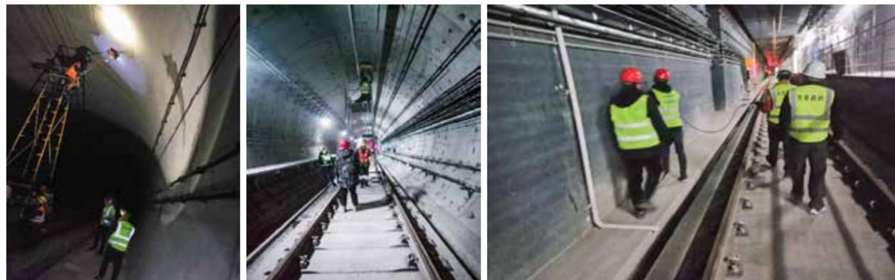
使用 900MHz 和 400MHz 天线可检测钢筋混凝土二衬和素混凝土二衬中的病害（脱空、空洞、不密实）和衬砌厚度。
