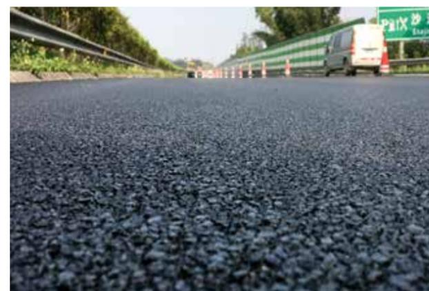
※ **超粘超弹薄层罩面:**
