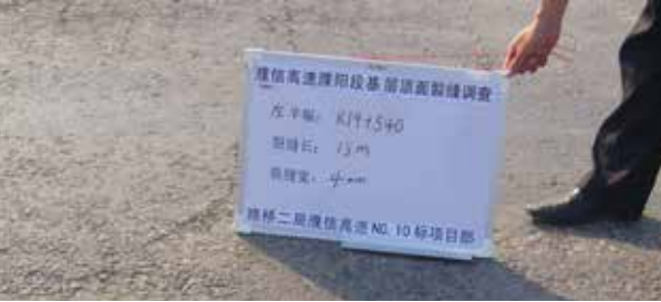
图 2 十标裂缝统计照片
