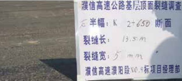
图 3 标注裂缝位置“F”照片
